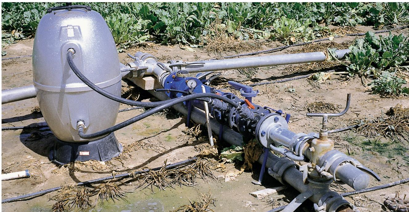
Estación de filtrado en una instalación de riego por goteo.
